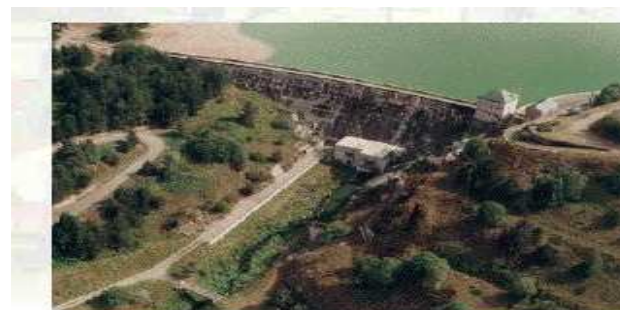
Barrage de Puyvalador
