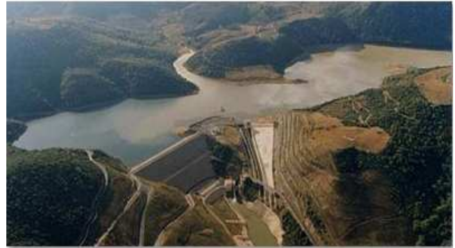
Le barrage de l'Agly (Caramany) en Novembre 1999
