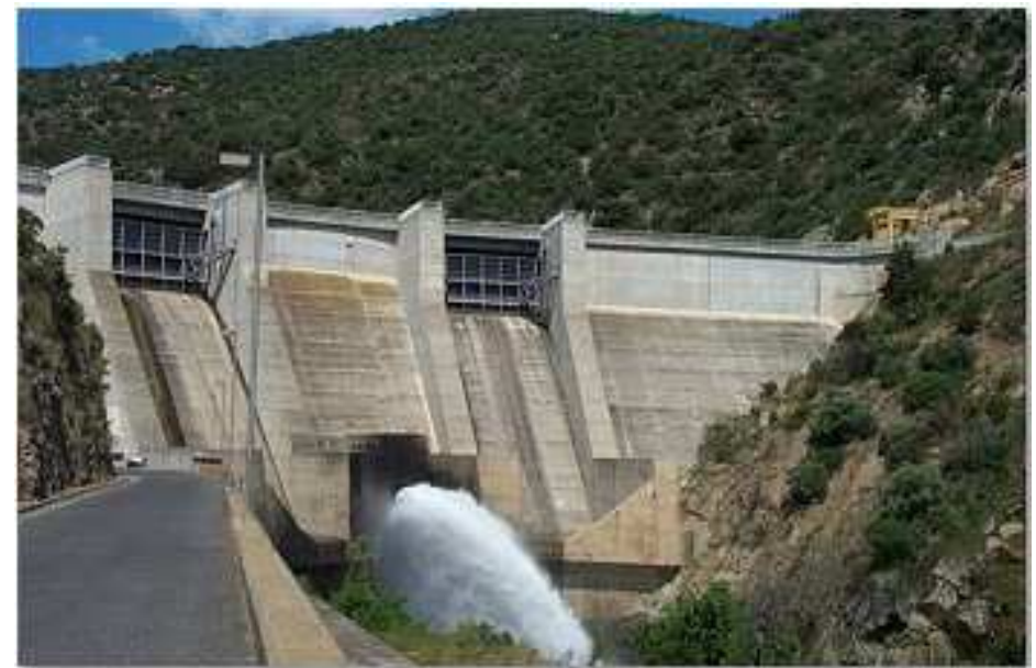
Le barrage de Vinça
